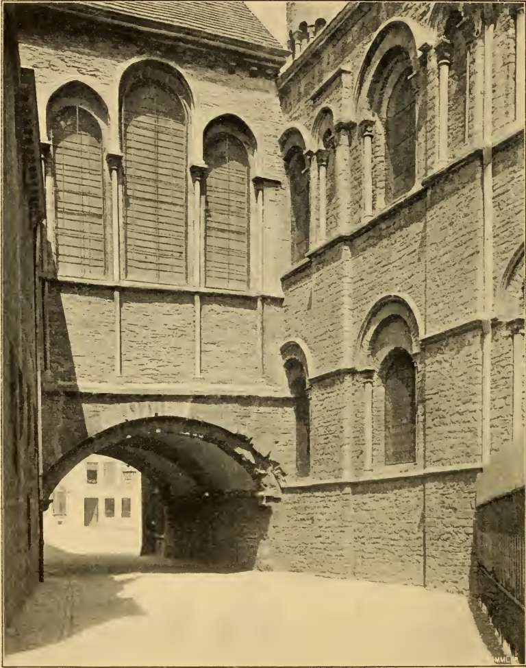
Abb. 75. Durchgangspforte zwischen der Kathedrale und der erzbischöflichen Residenz.
